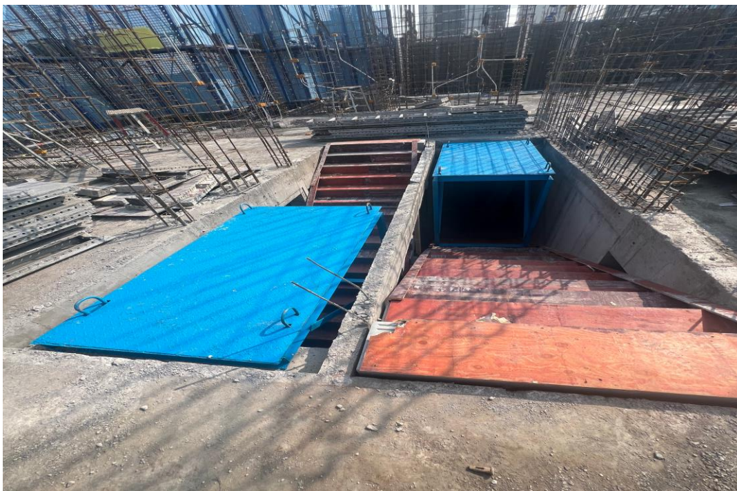
楼梯口布置定型式操作平台
