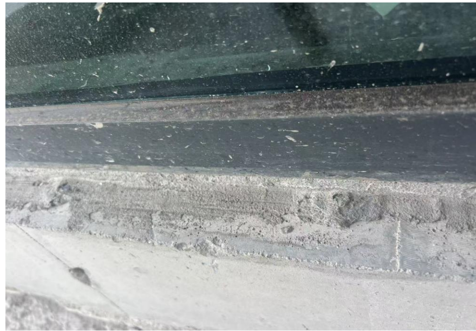
门窗水泥砂浆塞缝
