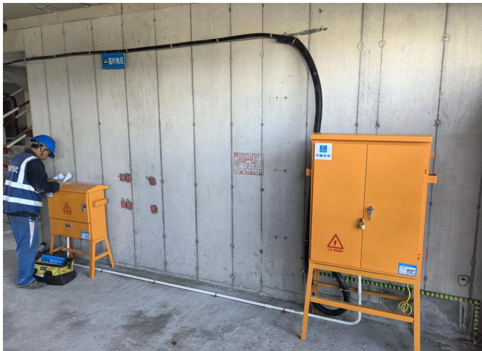
临时电缆进行架空绝缘
