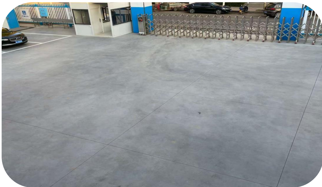
地坪深化排版，切缝整齐划一、分隔合理
