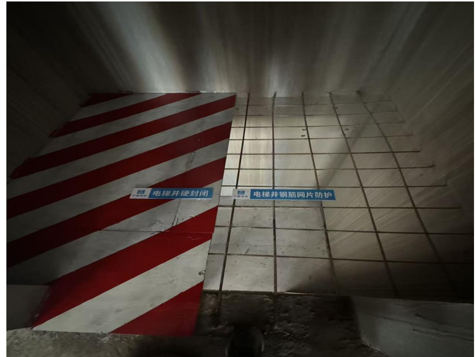
水平洞口设置预留钢筋
