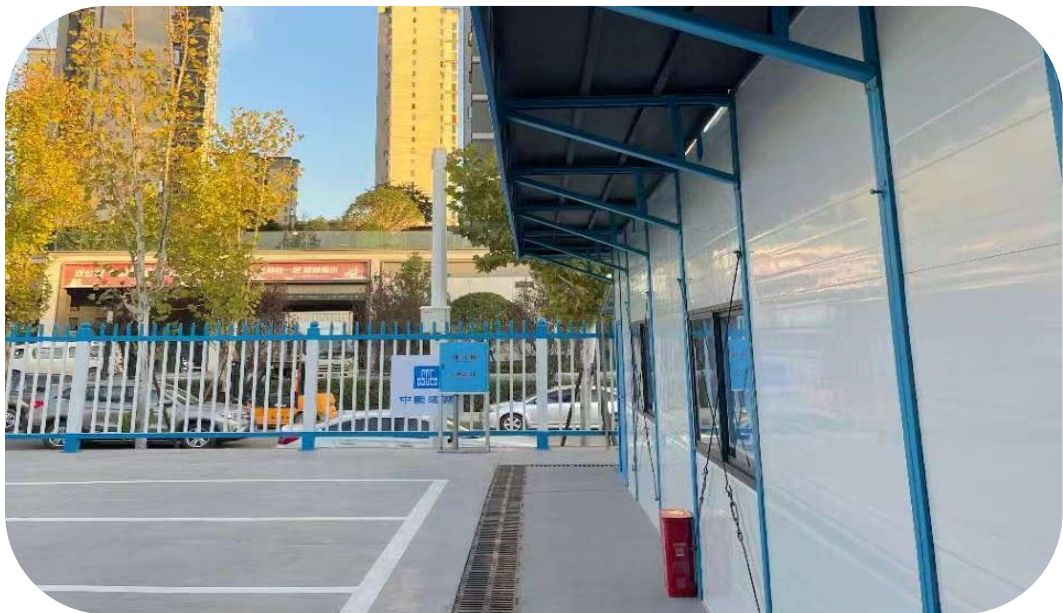
屋檐滴水落点位置与排水沟中点绝对垂直
