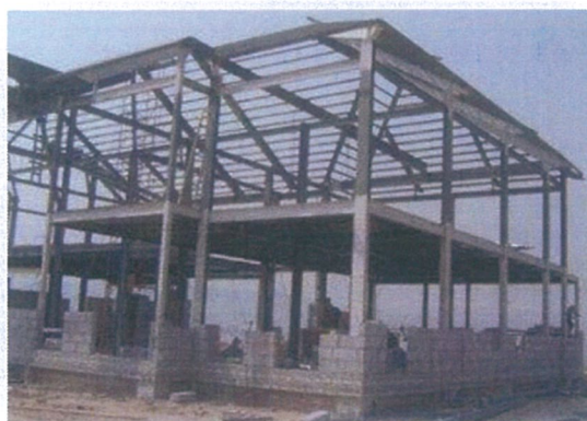
钢和混凝土混杂结构
