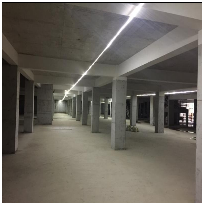
地下室、楼梯间采用 LED 节能灯照明
