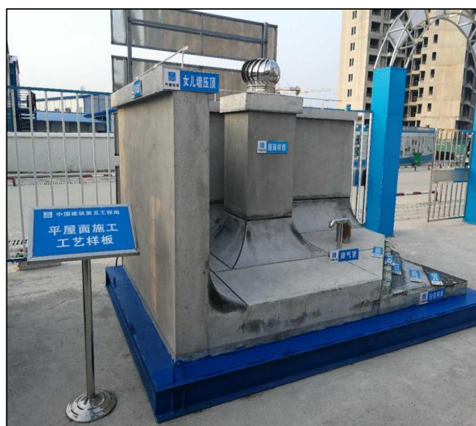
平屋面工艺样板
