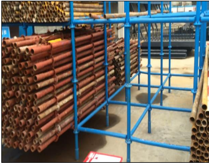
架管材料堆场
