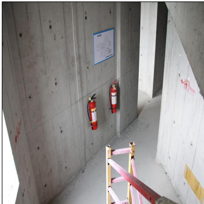
楼层内疏散通道
