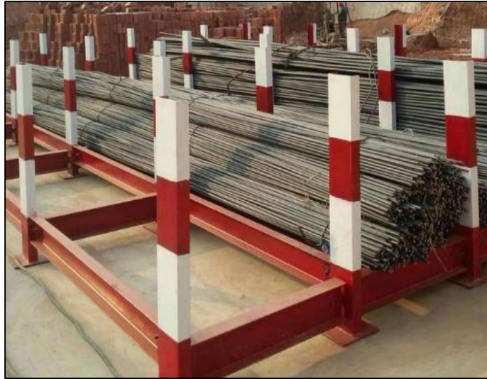
钢筋原材堆场
