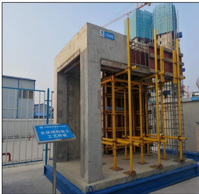
主体结构工艺样板
