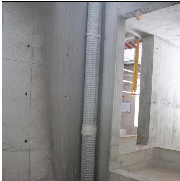
楼层内洗泵管砂浆管道
