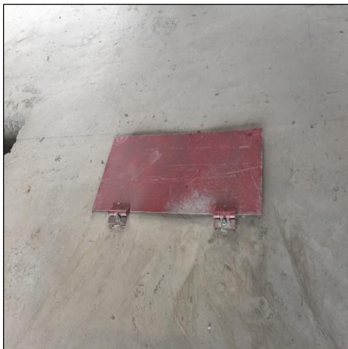
传料传料口、放线洞洞口防护
