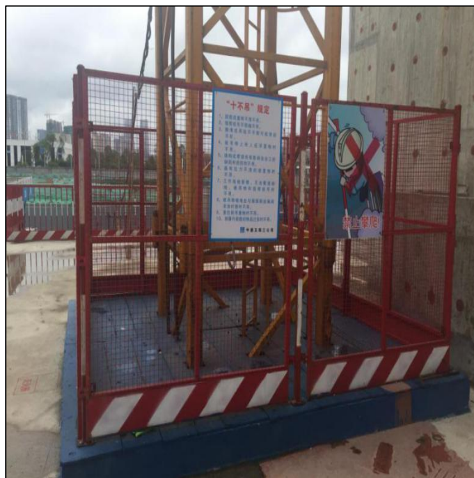
塔吊基础防护
