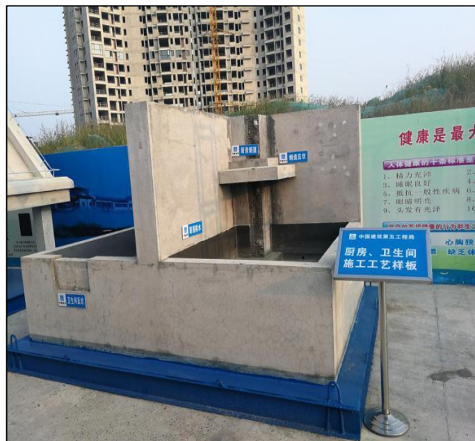
厨房、卫生间工艺样板
