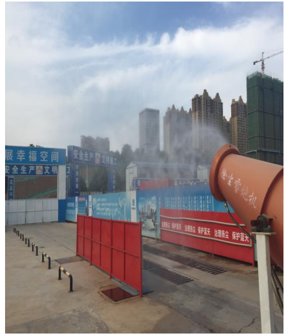
施工现场大门设置自动洗车槽和雾炮机，有效治理扬尘
