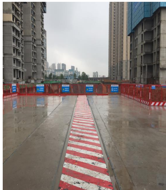
后浇带防护采用木板封闭隔离，刷红白色警示漆
