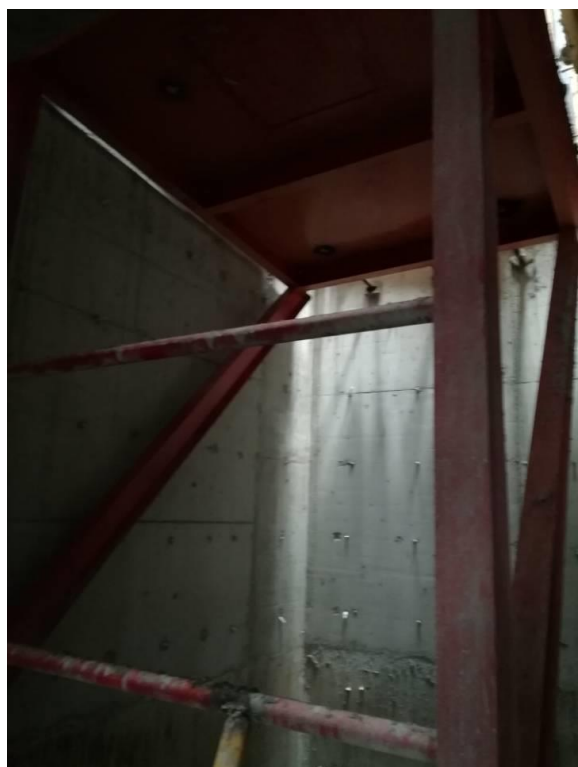
电梯井工具式操作支撑钢结构 无井架操作平台
