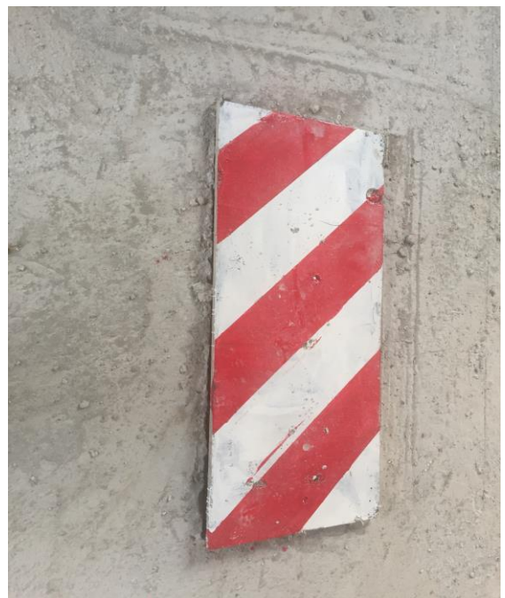
楼层水平洞口封闭
