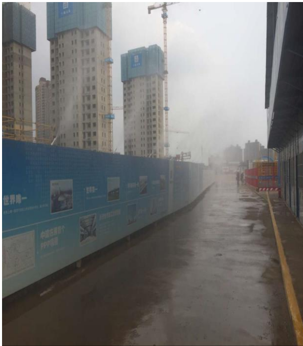
现场设置道路喷淋系统,可重复使用 彻底治理了扬尘
