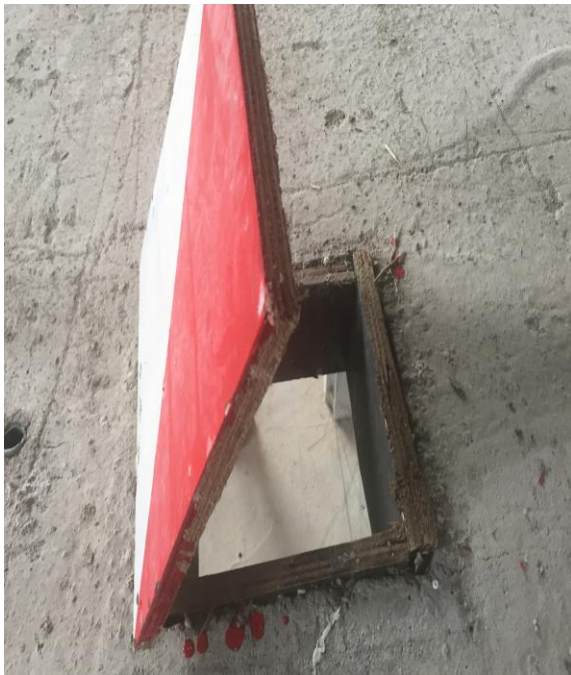
楼层放线洞采用可开启木盒封闭
