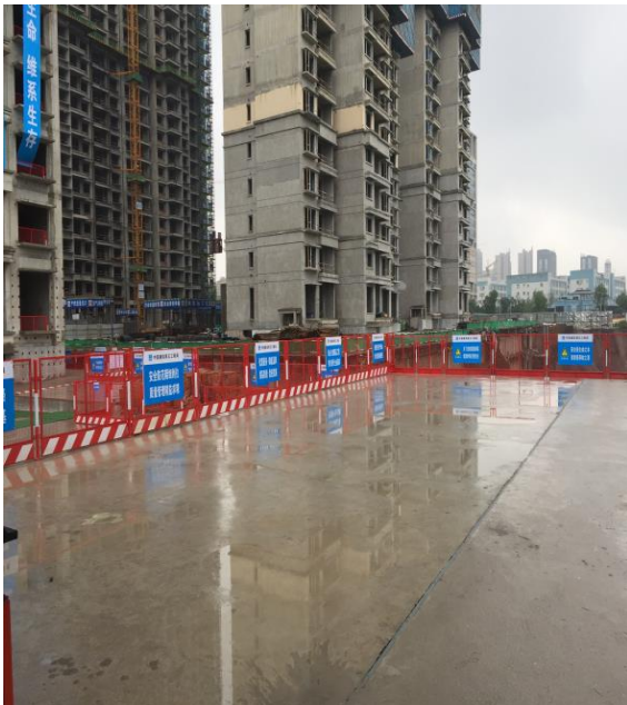
临边防护与场区隔离采用定型化网片式防护围栏，可重复周转使用，拆装简单。
