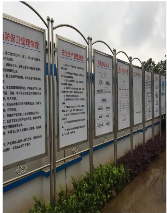
通道 现场大门设立九图一牌
