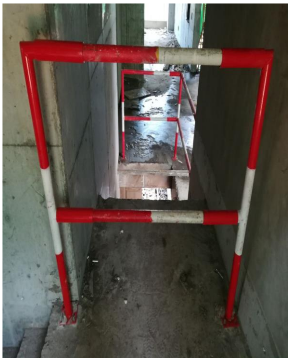
楼层临边洞口采用工具式栏杆防护
