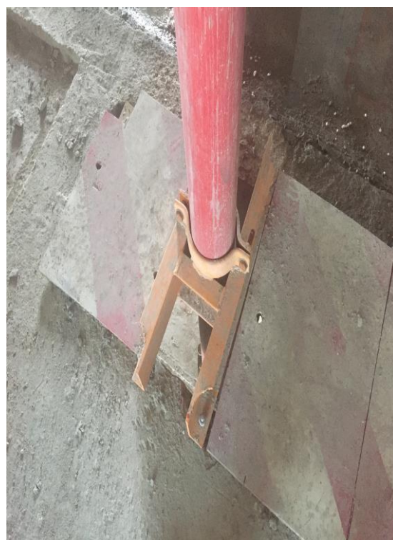
工具式泵管洞口封闭加固
