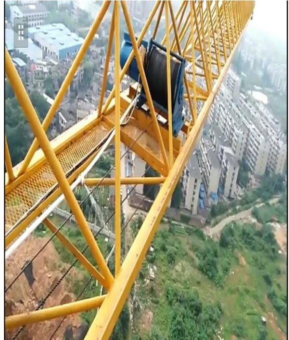
塔吊喷淋系统,可重复使用有效的治 理了扬尘
