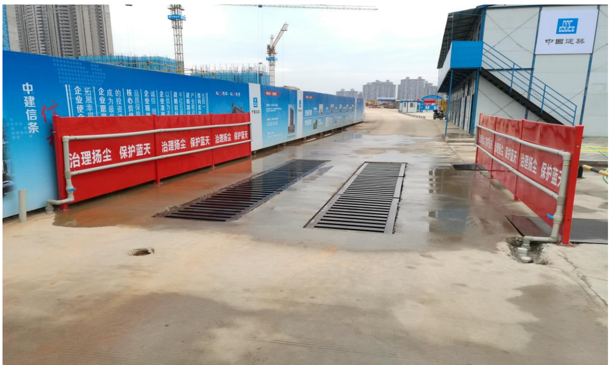
自动喷淋洗车系统，利用现代技术实现自动控制，并实现节水节能。
