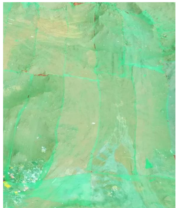
现场裸土覆盖,采用废旧安全网,有 效治理了扬尘
