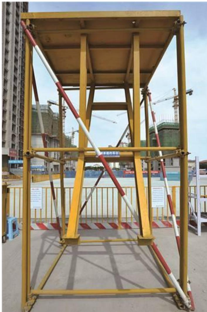
施工现场作业层电梯井内采用工具式操作平台，提升简单，安全
