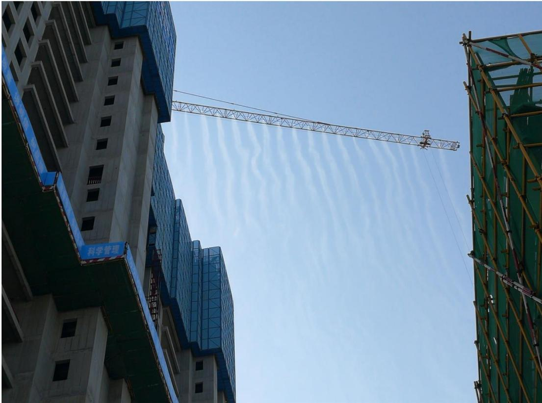
塔吊喷淋系统，对现场扬尘进行控制
