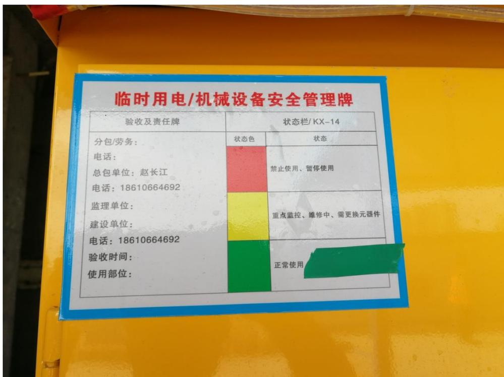
项目部自制配电箱验收牌，通过贴彩色电胶布标注配电箱情况，实现对配电箱动态管理
