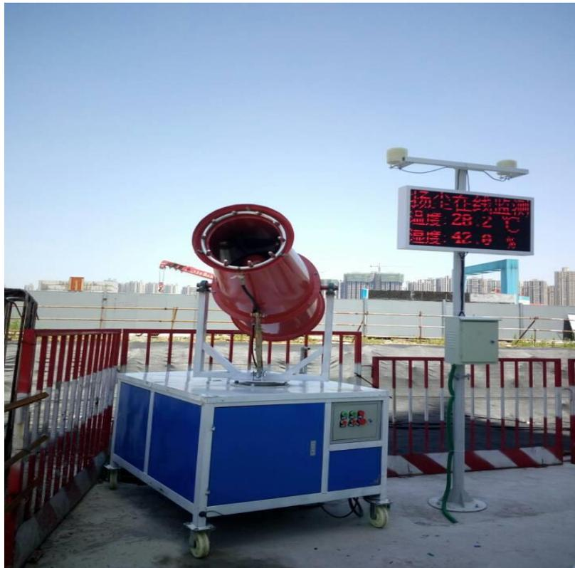
施工现场引进雾炮机，对板面及 基坑扬尘进行全面治理
