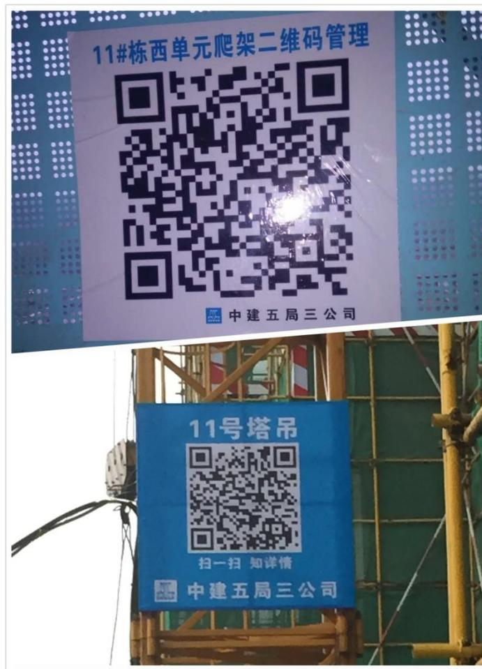
施工现场塔吊、人货电梯及爬架采用二维码动态管理，记录设备的基本信息及管理过程，保留现场管理痕迹
