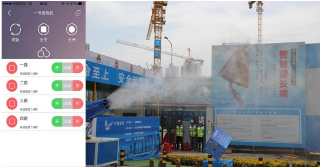
对现场雾炮机、喷淋系统进行手机实时控制
