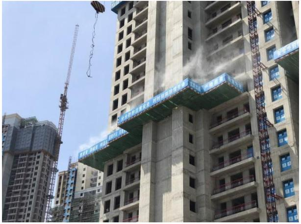
在爬架作业层及平挑层设置喷头，有效进行扬尘防治
