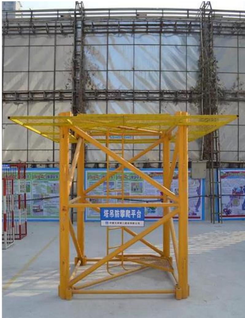
塔吊采用防攀爬架体，防止非操作人员随意攀爬塔吊。
