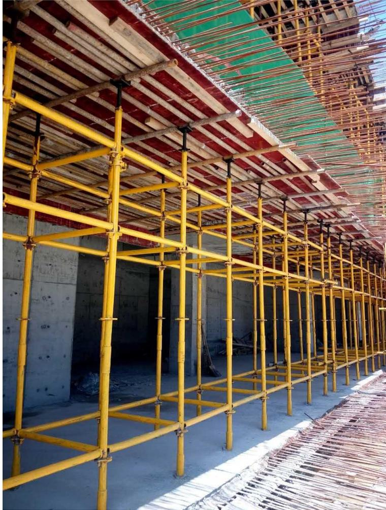
后浇带架体刷漆加以区分，避免拆除
